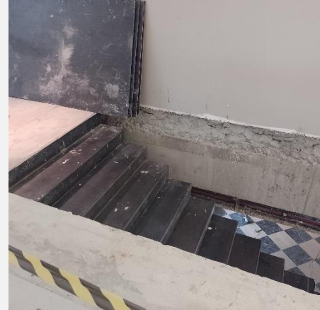
Abertura de escada para circulação direta entre o térreo e o primeiro pavimento do Metropolitan
