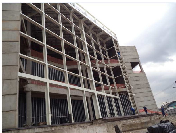
Fachada em 22 de julho de 2013
