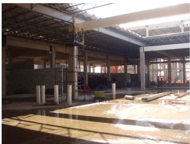
Obra em 15 de abril de 2013
