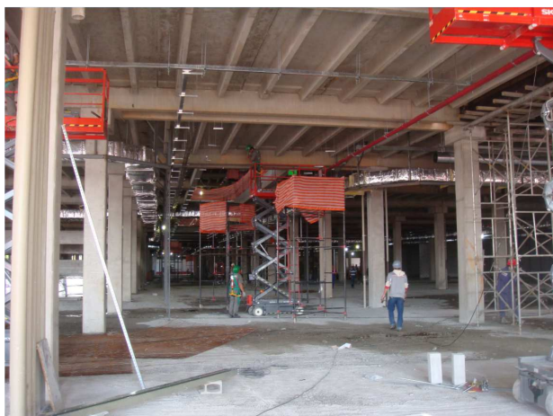
Obra em 15 de abril de 2013
