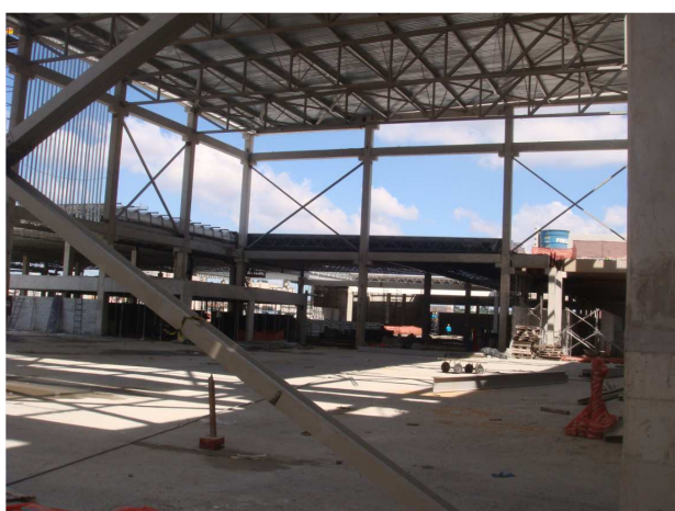
Obra do Cinema em 15 de abril de 2013
