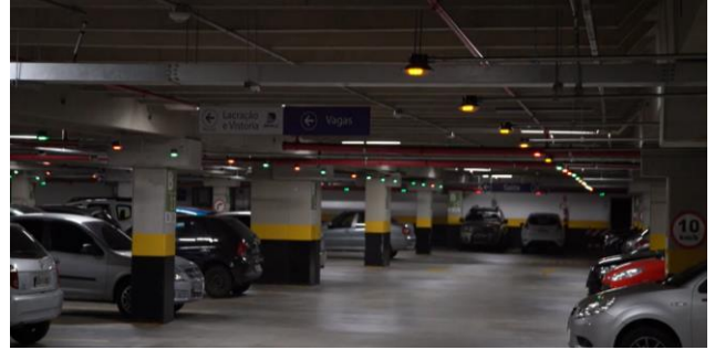
Estacionamento com 2.000 vagas cobertas
