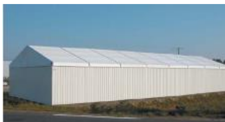
Exemple de bâtiment EXPRESS
