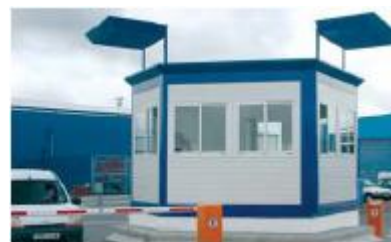
Exemple de bâtiment MODULAIRE
