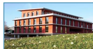
Immeuble de bureaux Exakis (Bidart)
