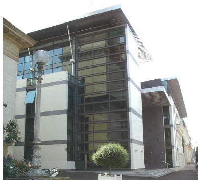
Activité de Construction : exemple de réalisation
