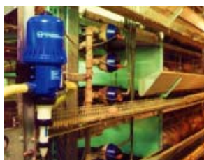
Traitement de l'eau
