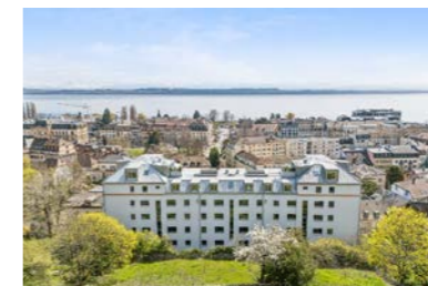
Neuchâtel, Faubourg de l'Hôpital
