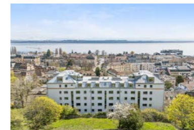
Neuchâtel, Faubourg de l'Hôpital
